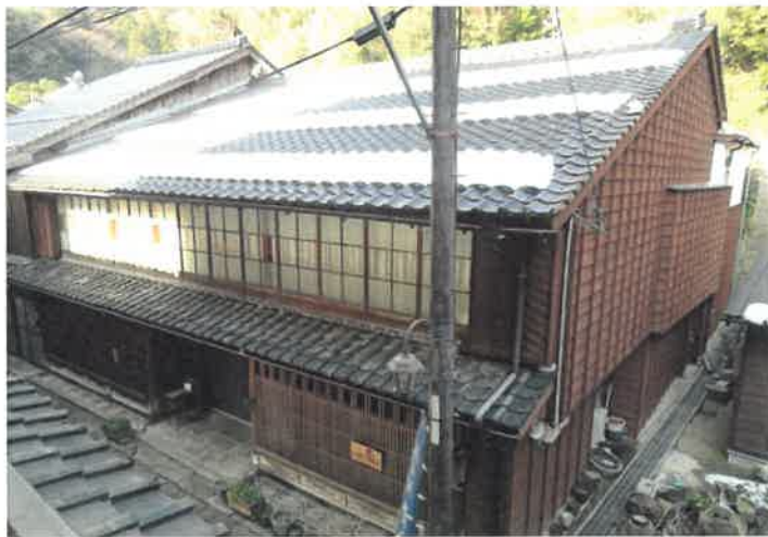
三代家住宅主屋 正面（南東側上方）外観
