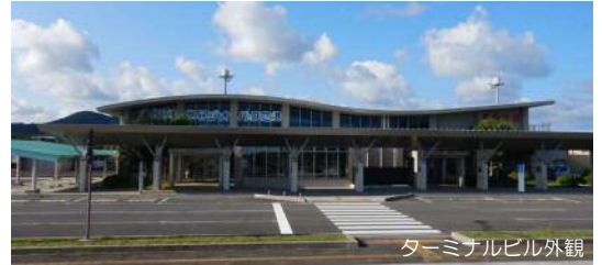
ターミナルビル外観
