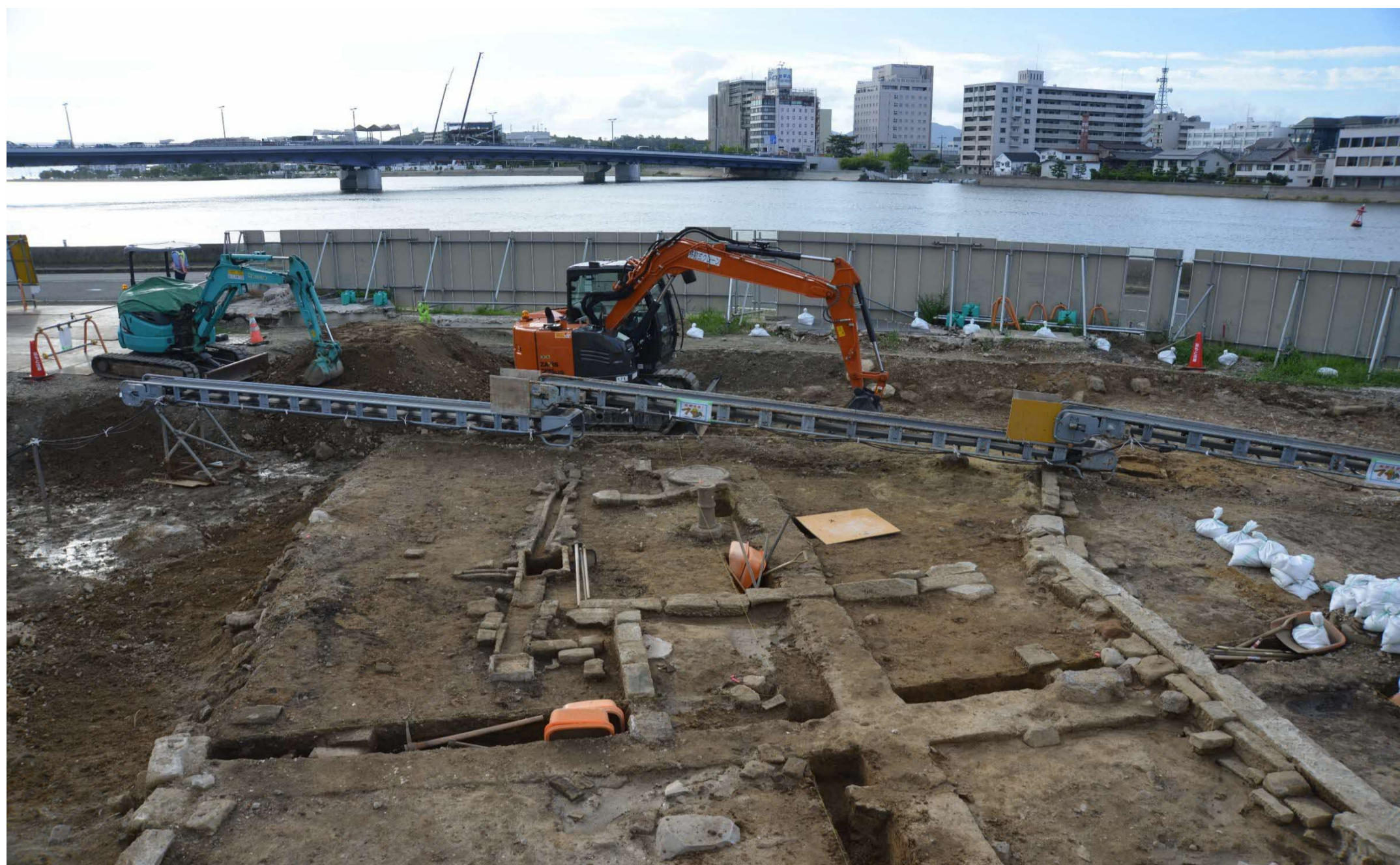
屋敷跡（1区、明治時代頃、東より）
