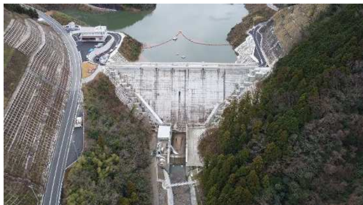
波積ダム状況写真（令和6年2月末）
