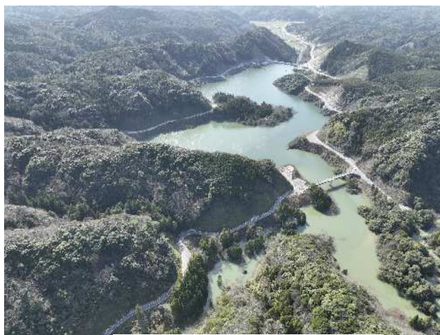
貯水池全景(上流より撮影) 【試験湛水時】
