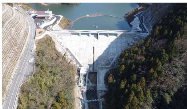
波積ダム本体（下流面）
