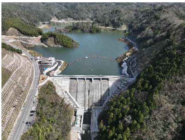
貯水池全景(下流より撮影) 【試験湛水時】
