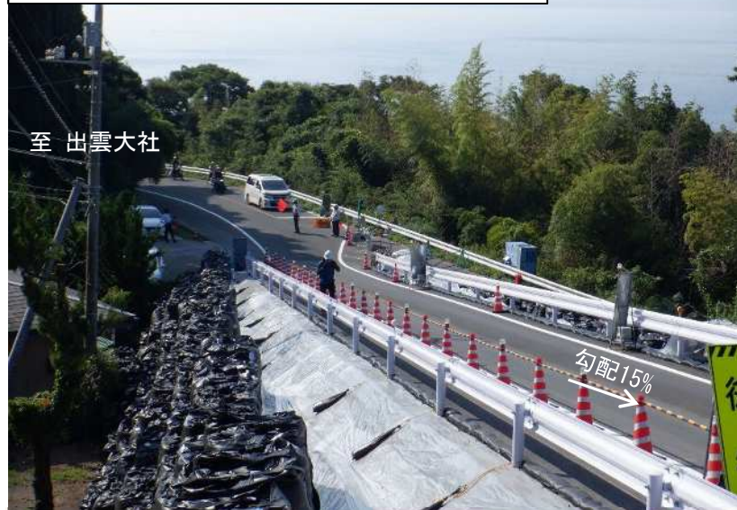
大型土のうを用いた坂路の状況写真
