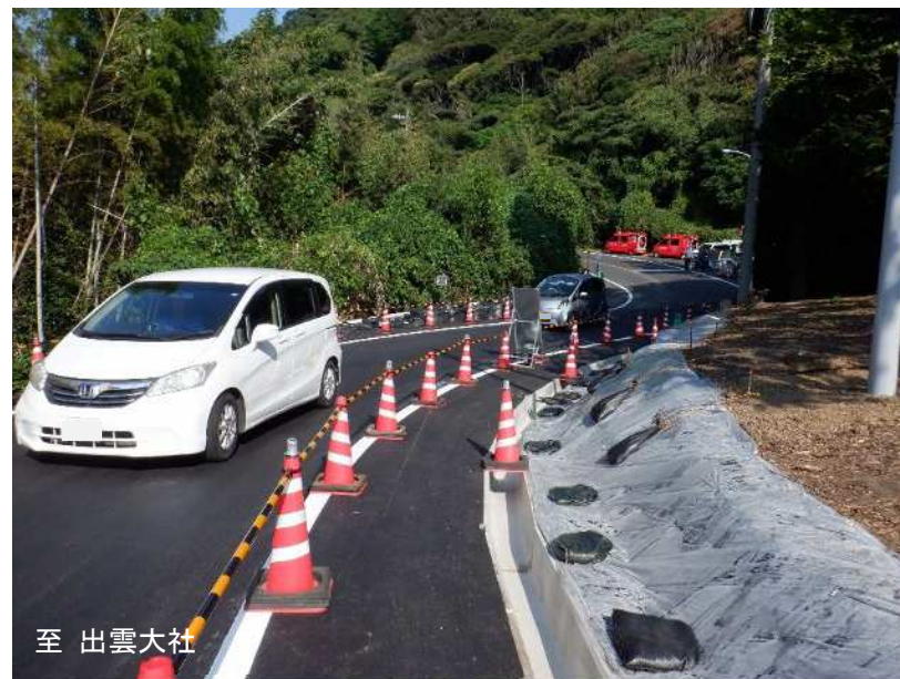
仮設迂回道路の状況写真
