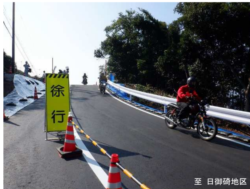
仮設迂回道路の状況写真
