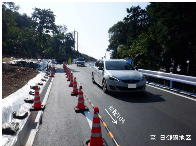
仮設迂回道路の状況写真
