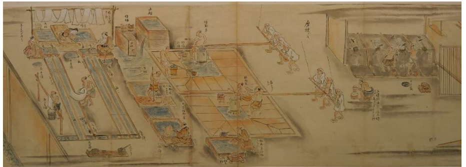
△採掘した鉱石を泥状になるまですり潰し、金銀を多く含む砂を選ぶ様子
