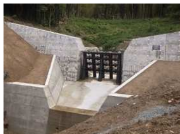
砂防堰堤工
