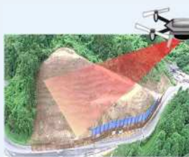
ドローンによる3D測量
