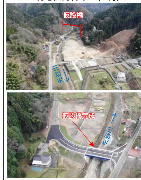
現地状況（令和7年4月）
