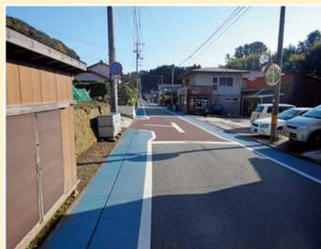
（一）池田中町線（隠岐の島町）
