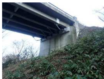
落橋防止構造
