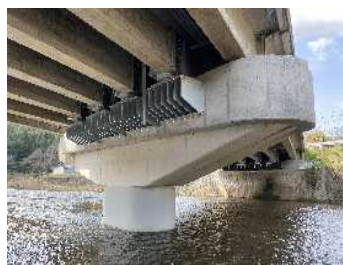
水平力分担構造
