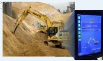
3Dデータを利用した機械施工
