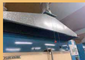
省エネ診断で設備の運用改善
