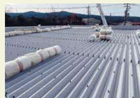
工場屋根の断熱改修
