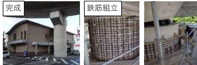
橋脚巻立の様子
