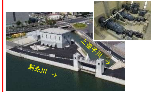
上追子川排水機場（R3.9完成）
