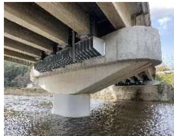
水平力分担構造
