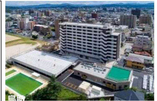
大輪団地（非現地建替） R元年竣工 鉄筋コンクリート造 10階建て 79戸 福祉施設併設
